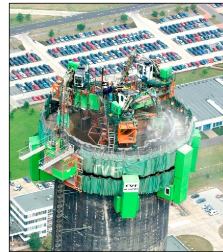
Mit einem eigens entwickelten Verfahren trägt TVF hohe Schornsteine stückweise ab
